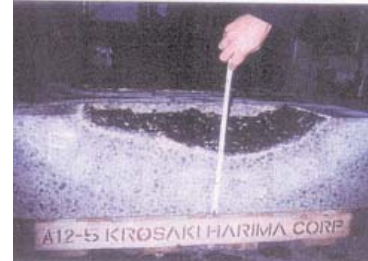
DAÑO CAUSADO POR ELFUEGO EN HORMIGÓN CON FIBRA METÁLICA – 118 mm de exfoliación
