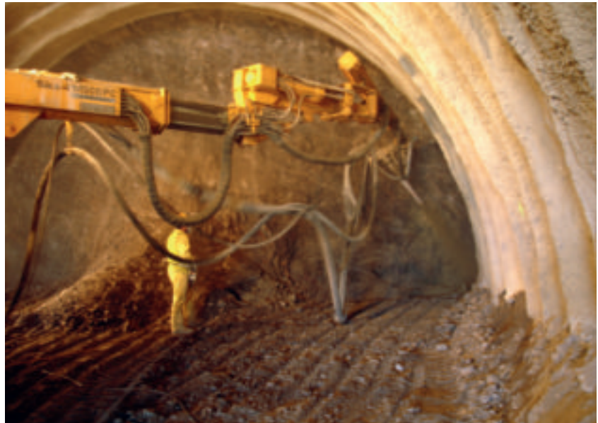
Gunitado con HFR (sintética) de la capa de revestimiento de un túnel.
