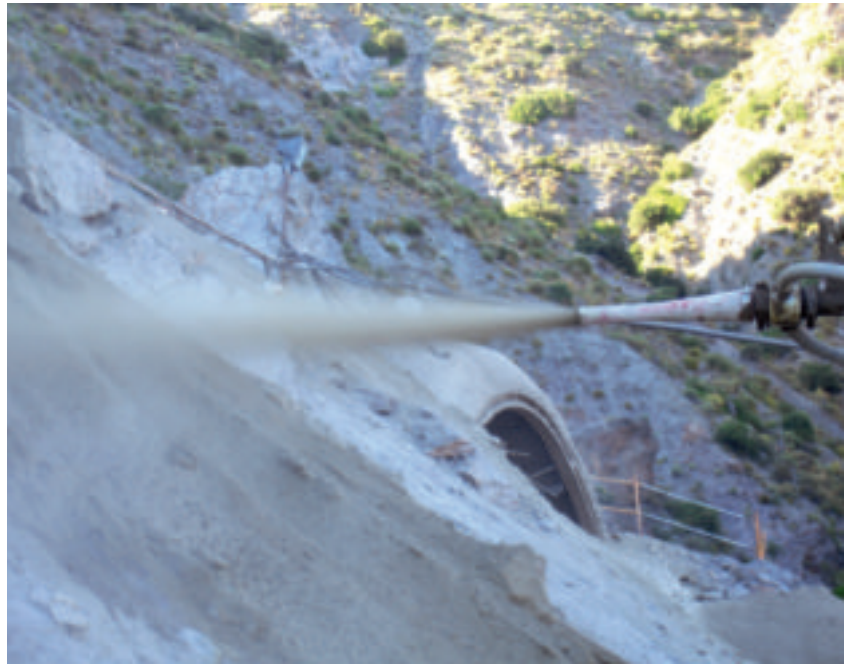
Gunitado con HFR de una ladera.
