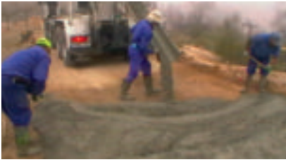
Realización de una carretera con HFR (sintética) en Almería.
