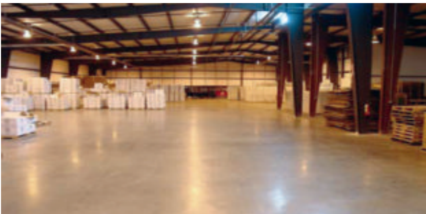
Solera industrial armada con fibra sintética estructural.
