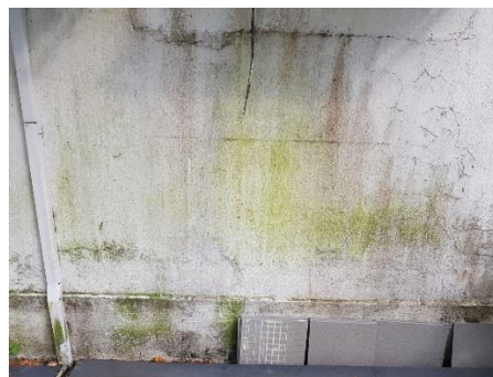
Pared después de solo 10 días aplicado el producto fotocatalítico
