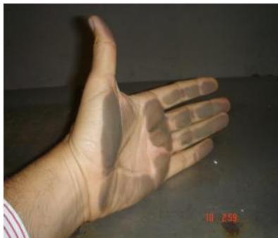
Pared de túnel después de un mes pintada con pintura estándar.
