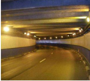
Túnel del Espinillo
