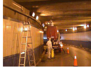
Limpieza y aplicación de las pinturas
